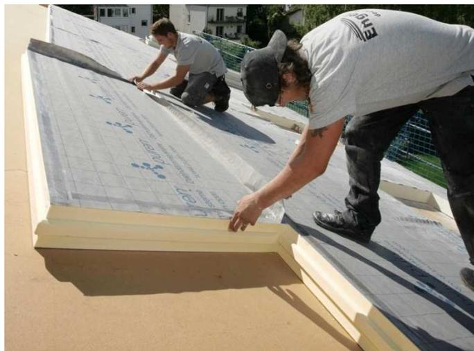
Fig. 7: Installation of PU rigid foam panels as above-rafter insulation. Source: Baustoffwissen, RM Handelsmedien GmbH & Co. KG: Dämmstoffe, Einsatzbereiche von PU-Hartschaum. URL: <https://www.baustoffwissen.de/baustoffe/baustoffknowhow/daemmstoffe/pu-hartschaum-polyurethan-daemmstoff-platten-einsatzbereiche-dach-boden-wand-wdvs-brandriegel-sandwich-elemente/> [Accessed: 14.06.2023]
