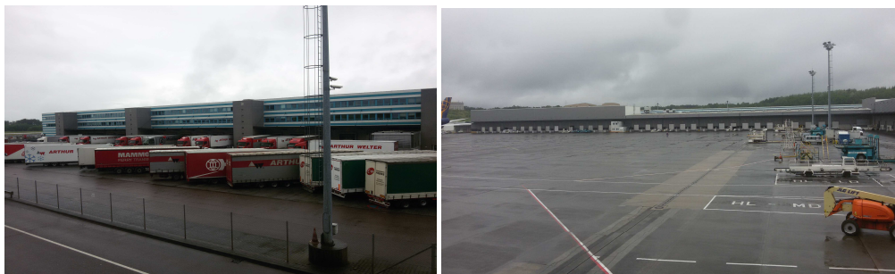
Abb 9 u. 10: Das Air Cargo Center landside und airside am Aéroport du Luxembourg (LUX)
