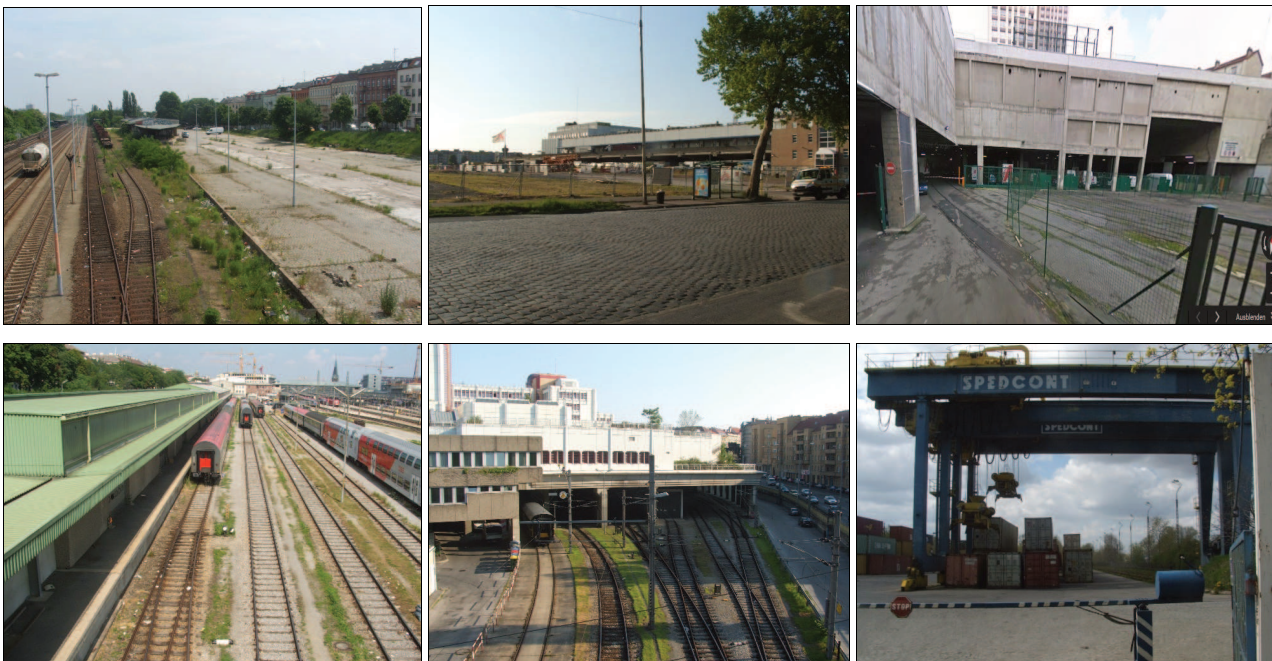
Abb. 4-9: Hoffungsstandorte in Berlin (am mittlerweile wiederhergestellten Südring), Brüssel (ehemaliger Güterterminal Thurn&Taxis), Paris (ehemaliger Bezirksgüterterminal Les Gobelins am eingestellten Güterrings Petite Ceinture-Sud); Wien (Güterhallen am Westbahnhof und am Franz-Josefs-Bahnhof) und Warszawa-Wola (Containerumschlagstation)
