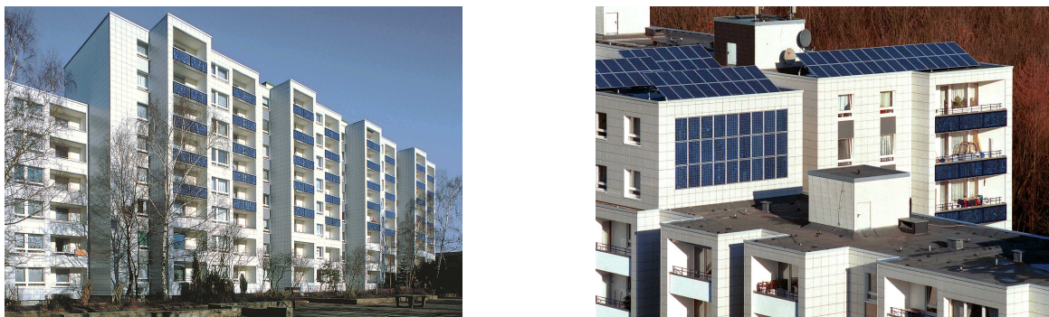
Abb.6: Gebäudeintegrierte Photovoltaik in der Solarsiedlung Köln-Bocklemünd, Sanierung einer 70er-Jahre Siedlung
