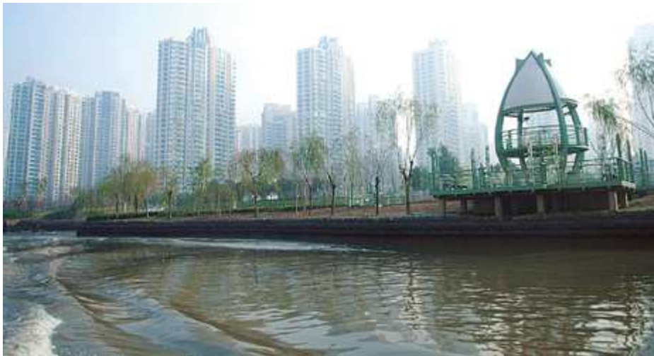
Abb. 19: Suzhou Fluss in Shanghai nach den Baumaßnahmen (Foto: Tan)
