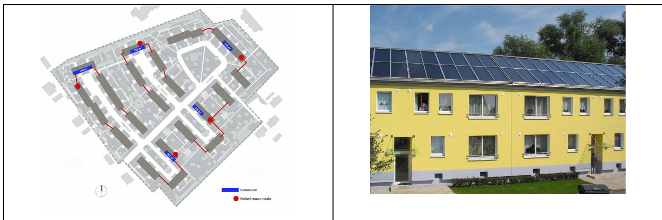
Abb.7: Solarthermische Nahwärme in der Solarsiedlung Gelsenkirchen-Lindenhof, Sanierung einer 50er-Jahre Siedlung
