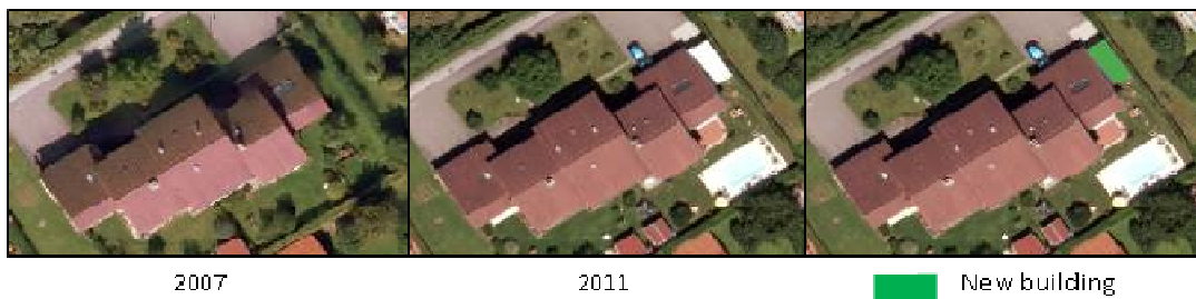
Fig. 7: Ein richtig klassifizierter Gebäudezubau.
