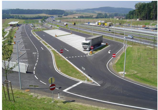
Abbildung 3: Verkehrliche Trennung von LKW und PKW sorgt für mehr Sicherheit
